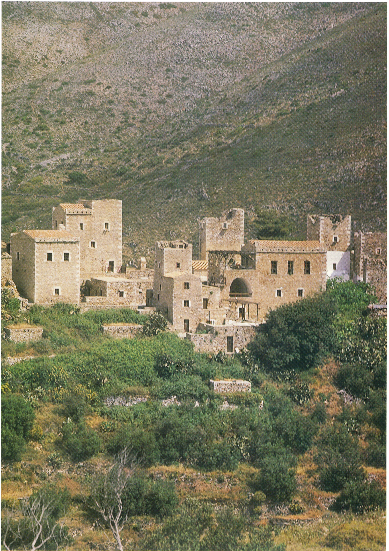
Βάθεια Μάνης. Η γειτονιά των αναστηλωμένων κτιρίων από τον Ε.Ο.Τ. Ήδη λειτουργούν σαν ξενώνες δίνοντας ζωή στον οικισμό που αργοπέθαινε. (φ. Ε.Ο.Τ.).
