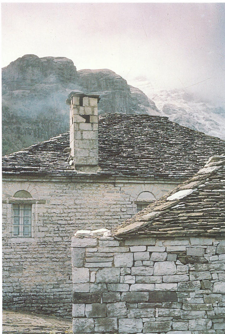
Πάλιγχο Ηπείρου. Το παραδοσιακό κτίριο Ιωαννίδη, (1847) μετά την αποκατάσταση και την διαμόρφωσή του σε ξενώνα από τον Ε.Ο.Τ. (Αρχιτ. Δημ. Καβδαδίας 1984 - φ. Ε.Ο.Τ.).
