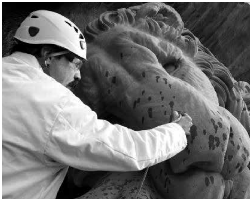
Εικ. 15. Εργασίες καθαρισμού και συντήρησης του Λέοντος της Λουκέρνης, μετά το ατυχές συμβάν του 2009 (Προσωπικό αρχείο Ι. Σπηλιοπούλου)
